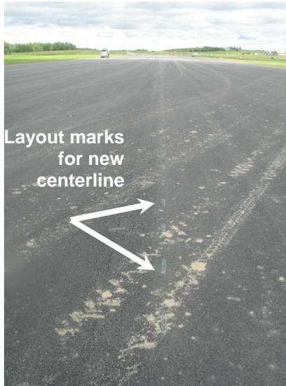
**FIGURE 6-2. CONSTRUCTION DIRT MUST BE CLEANED.**
