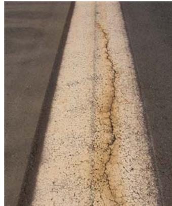
**FIGURE 4-27. EVIDENCE OF RUST CONTAMINATION FROM SUBSTRATE.**
