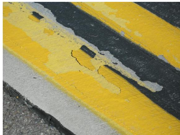
**FIGURE 2-1. PEELING PAINT LAYERS**
