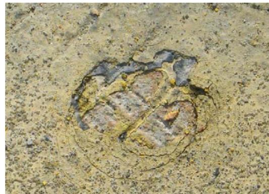
**FIGURE 6-7. MULTIPLE LAYERS OF PAINT FILL THE GROOVES.**
