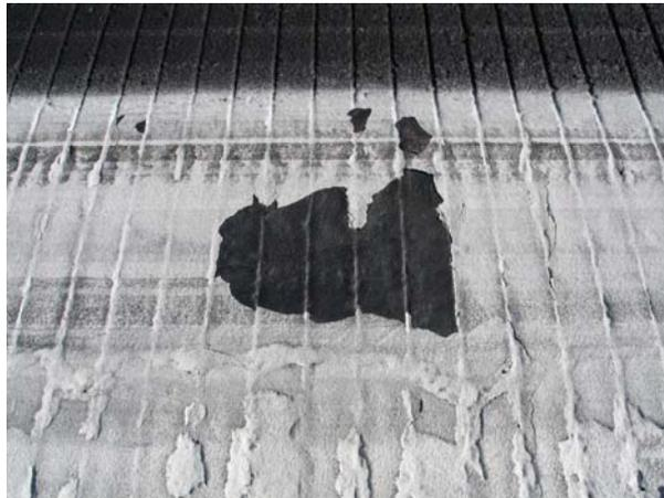
**FIGURE 5-7. PAINT IS PEELING OFF OF REJUVENATOR APPLIED OVER OLD MARKINGS.**
