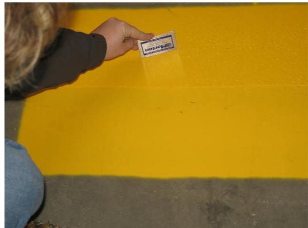
**FIGURE 6-62. USE OF WET FILM GAUGE.**
