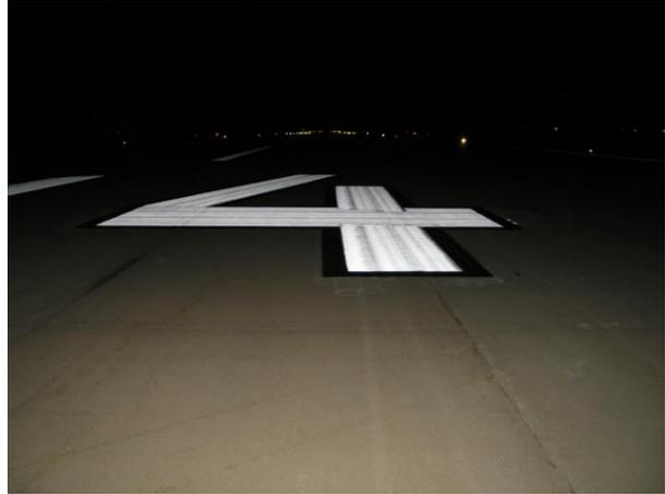
**FIGURE 6-52. NIGHTTIME VISIBILITY OF FIGURE 6-51 IS EXCELLENT.**
