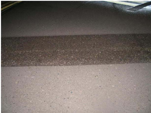
**FIGURE 5-20. A SCAR FROM ULTRA-HIGH-PRESSURE WATERBLASTING ON GOOD ASPHALT.**
