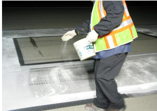
**FIGURE 6-33. HAND-THROWN GLASS BEAD APPLICATION IS UNEVEN, POORLY DISTRIBUTED, AND POORLY EMBEDDED.**
