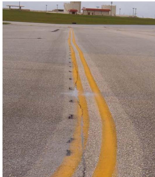
**FIGURE 2-4. MARKING IS OUT OF ALIGNMENT**
