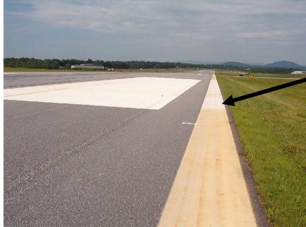
**FIGURE 4-25. GROOVED SURFACE MAKES STAIN LESS NOTICEABLE.**
