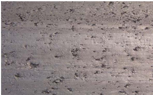
**FIGURE 4-9. BEFORE RUBBER REMOVAL.**
