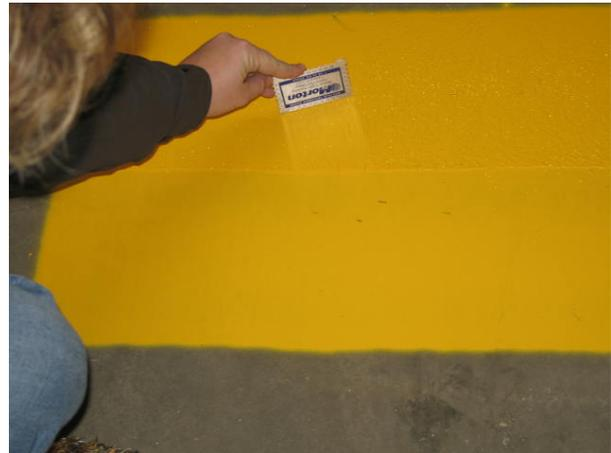
**FIGURE 6-62. USE OF WET FILM GAUGE.**
