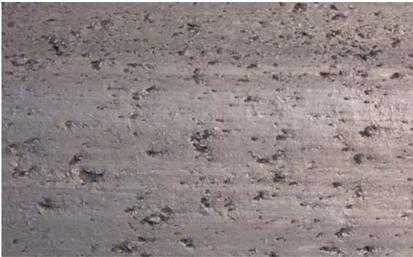
**FIGURE 4-9. BEFORE RUBBER REMOVAL.**
