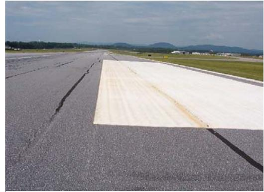
**FIGURE 6-13. JOINT MATERIAL DISCOLORS THE WHITE PAINT.**
