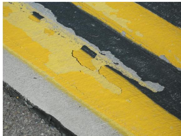
**FIGURE 2-1. PEELING PAINT LAYERS**
