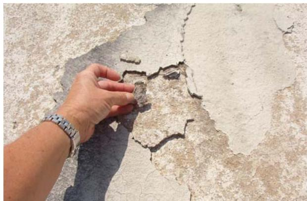
**FIGURE 5-6. HEAVY PAINT BUILD UP ON CONCRETE.**
